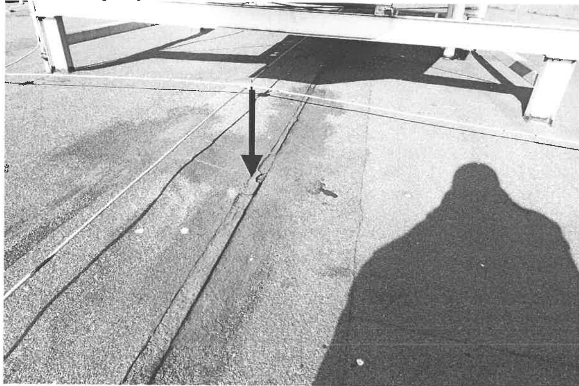
uszkodzenie pokrycia
